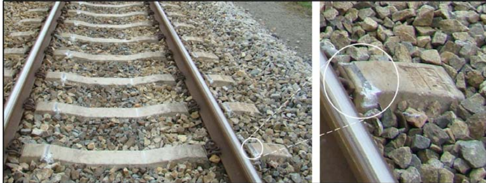
Afbeelding 16: voorbeeld van uitgesmeerd metaal op bovenzijde van dwarsliggers (foto: KLPD)
