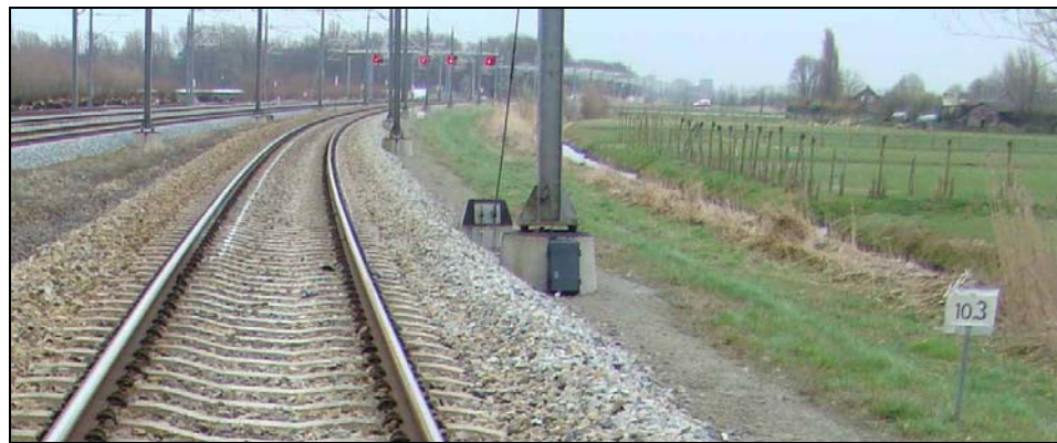
Afbeelding 8: foto van de infrastructuur bij ontsporingpunt km 10.3
