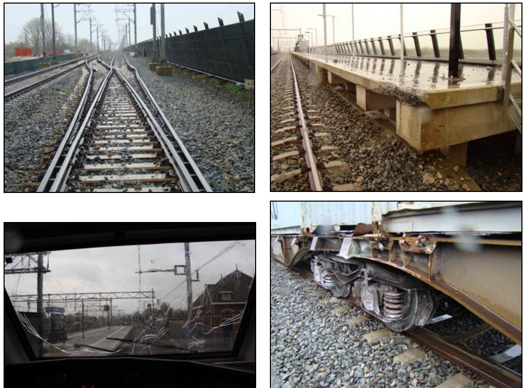
Afbeelding 5: foto's van schade aan infrastructuur, voorruit reizigerstrein en ontspoorde draaistel goederentrein (foto: KLPD)
